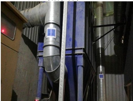
脉冲袋式除尘器及采样口
