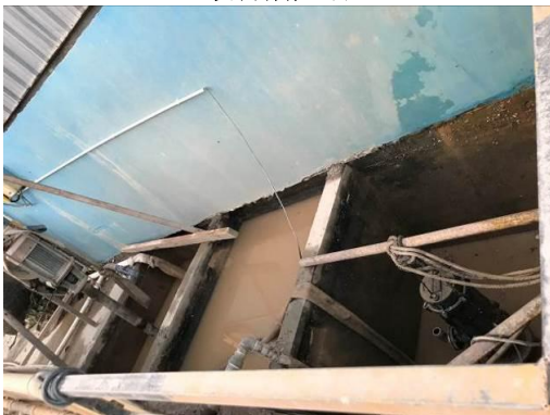
项目沉淀水池
