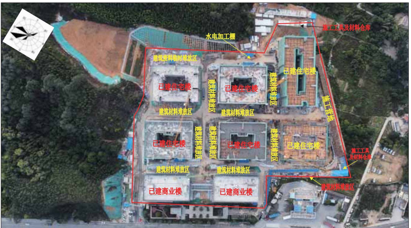
图 2.1-1 本场地现状航拍图
