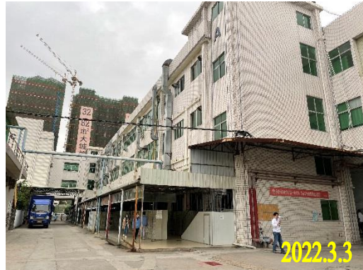
项目北面工业厂房
