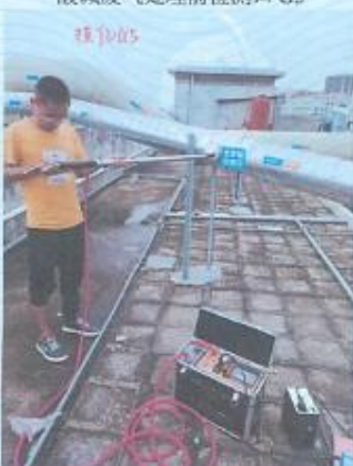
喷砂废气处理前检测口 G5
