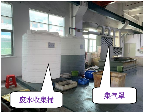
废水收集桶及清洗工位
