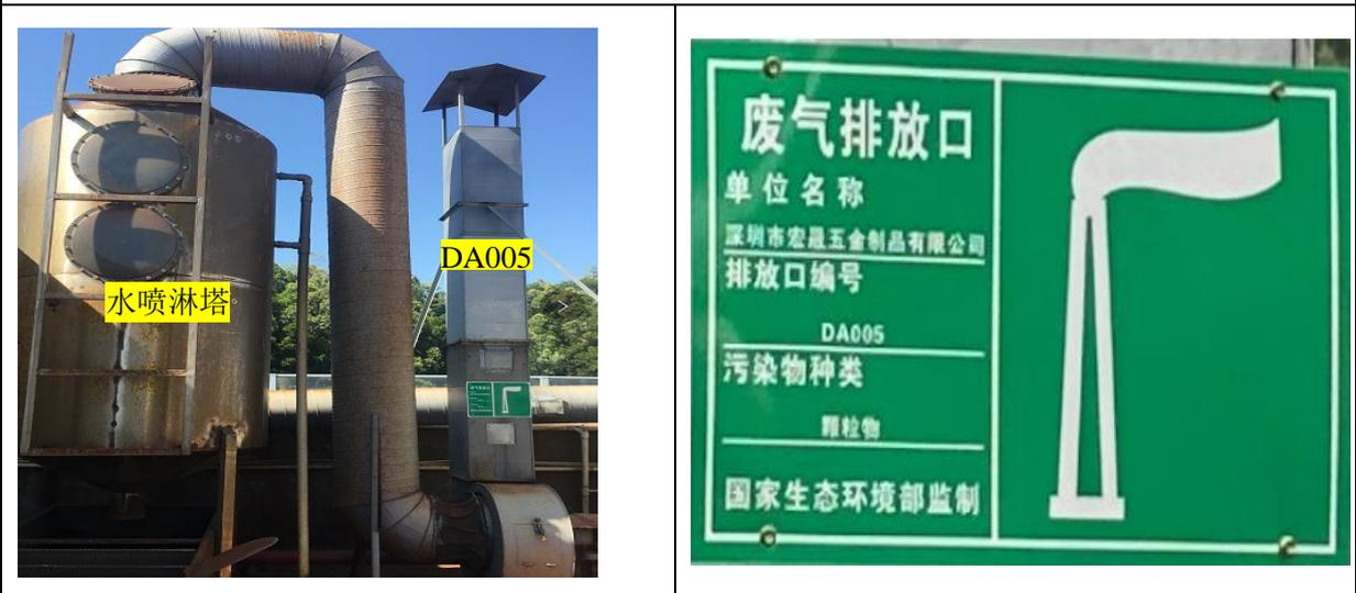
喷砂废气治理设施①：“水喷淋塔+DA005排气筒”
