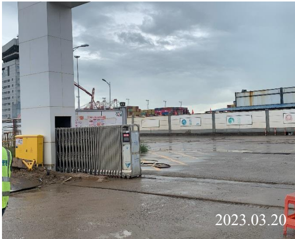
项目西面经一路（在建）
