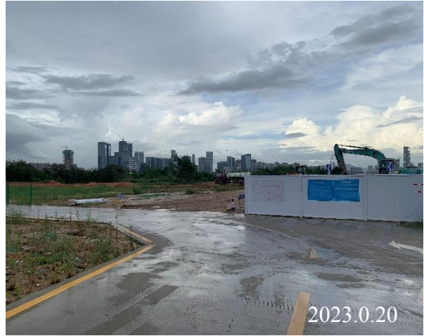
项目东面经二路（在建）
